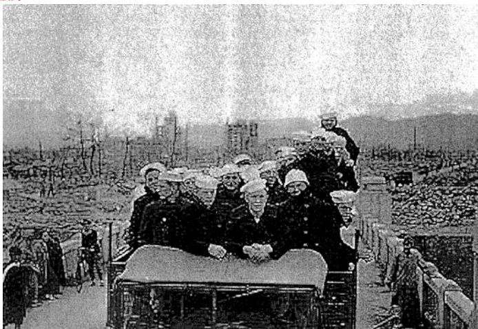
京橋上でトラックに乗った米兵と廃墟の広島(1945年9月下旬)
